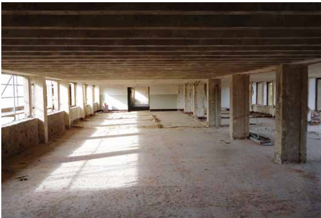
Abb. 11 Block II, südlicher Teil, sogenannte Liegehalle, 2015
