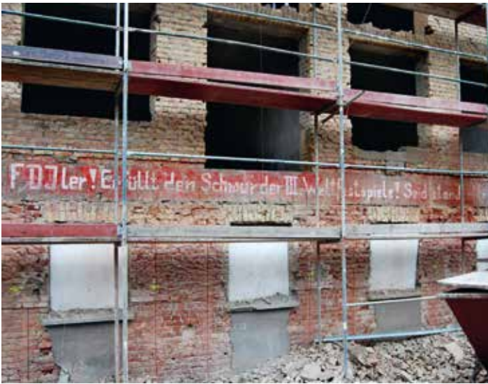
Abb. 7: Block II, nördlicher Teil, Seeseite, 2014
