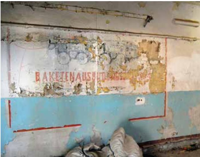
Abb. 8: Block II, nördlicher Teil, 2013
