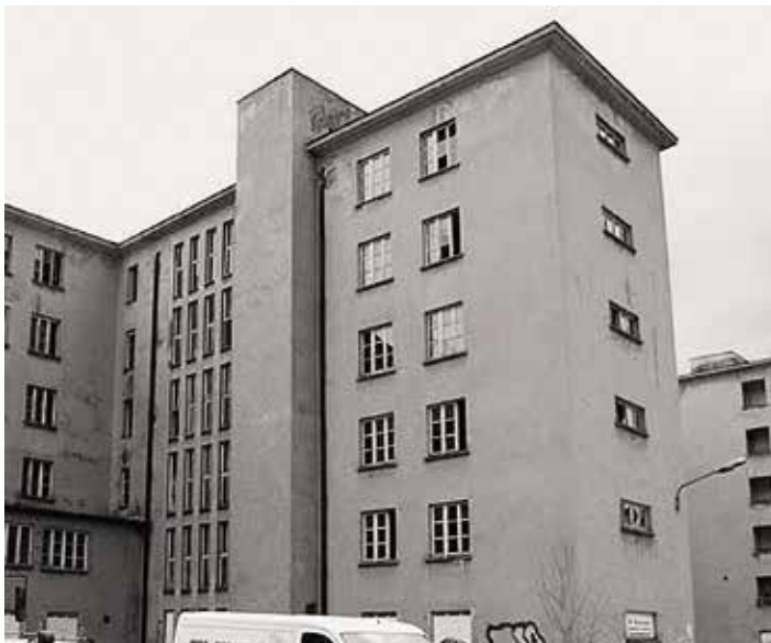
Abb. 3 Block II, nördlicher Teil, 2013
