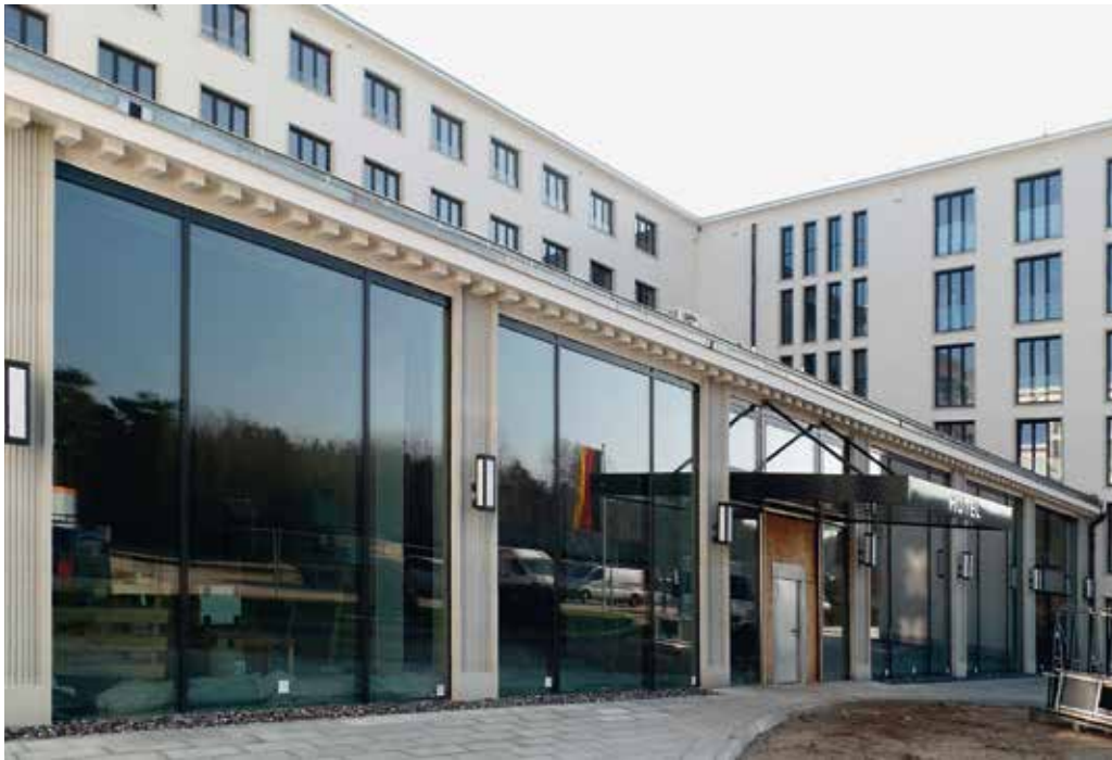
Abb. 14 Block II, südlicher Teil, Hotel, Eingangsfassade, 2016
