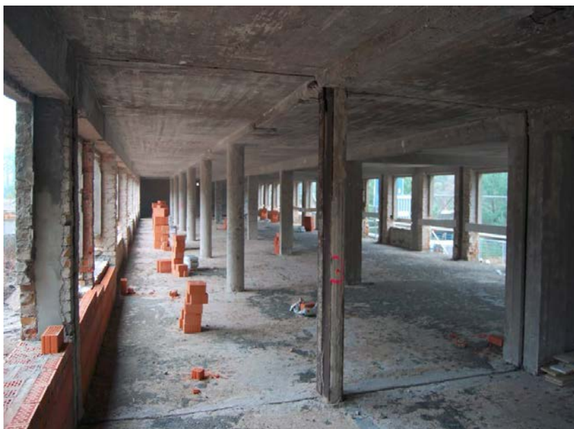
Lichthof 10, 1. OG, Blick vom TH 10 nach Norden
