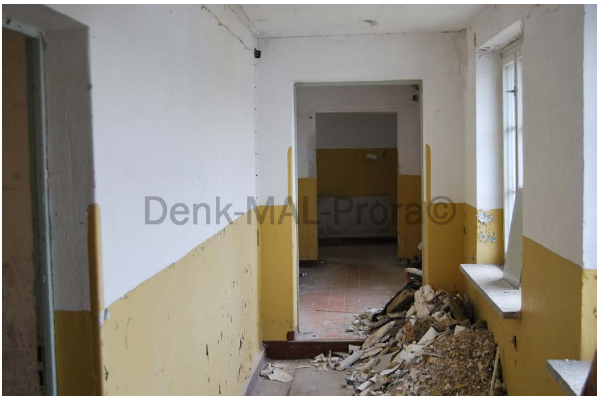
5. OG, Blick in Richtung Sanitärzellen (TH)
