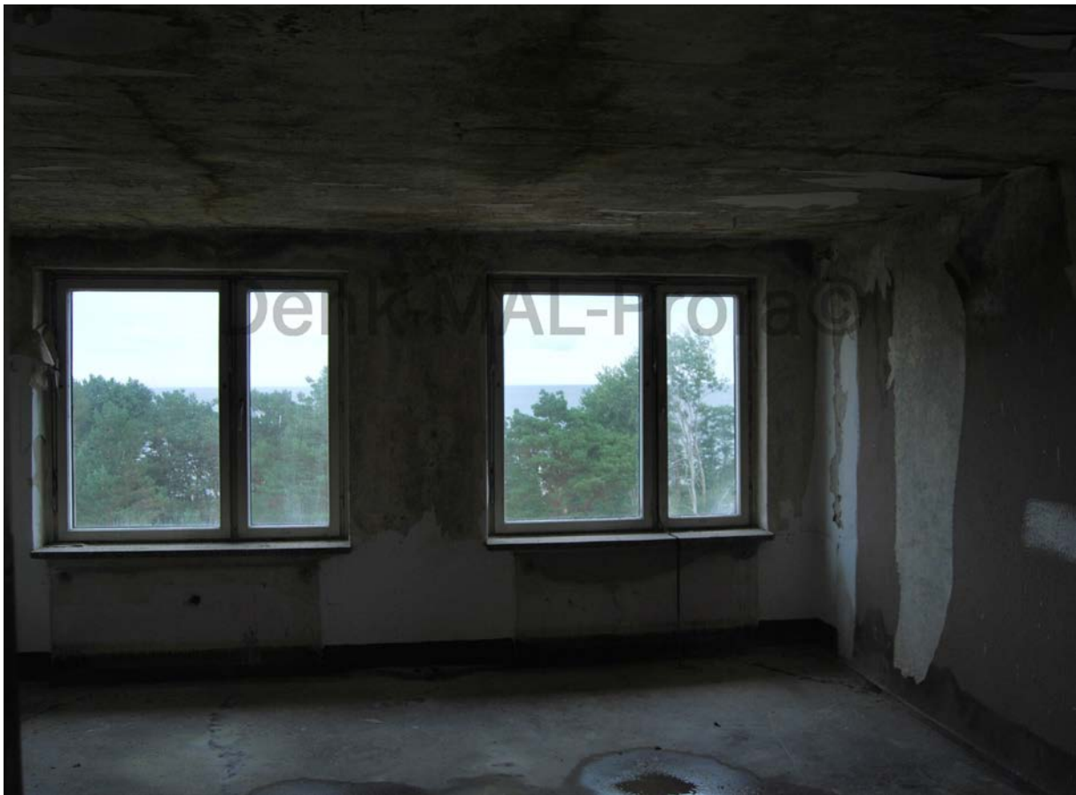
Weiteres Übungszimmer mit den Resten der Schallisolierung:
