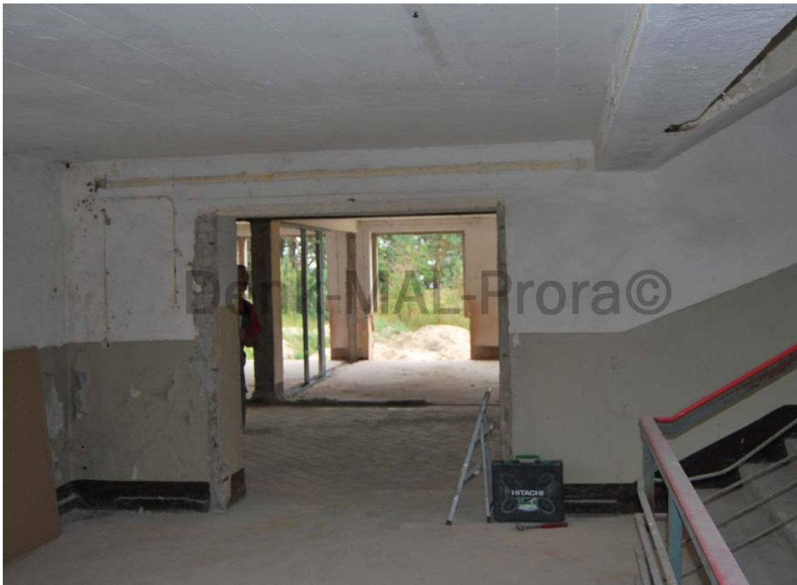
Im 1. OG beginnen 2013 die Entkernungsarbeiten
