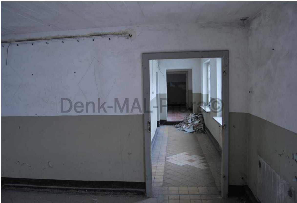
Zugang zum Sanitärtrakt:
