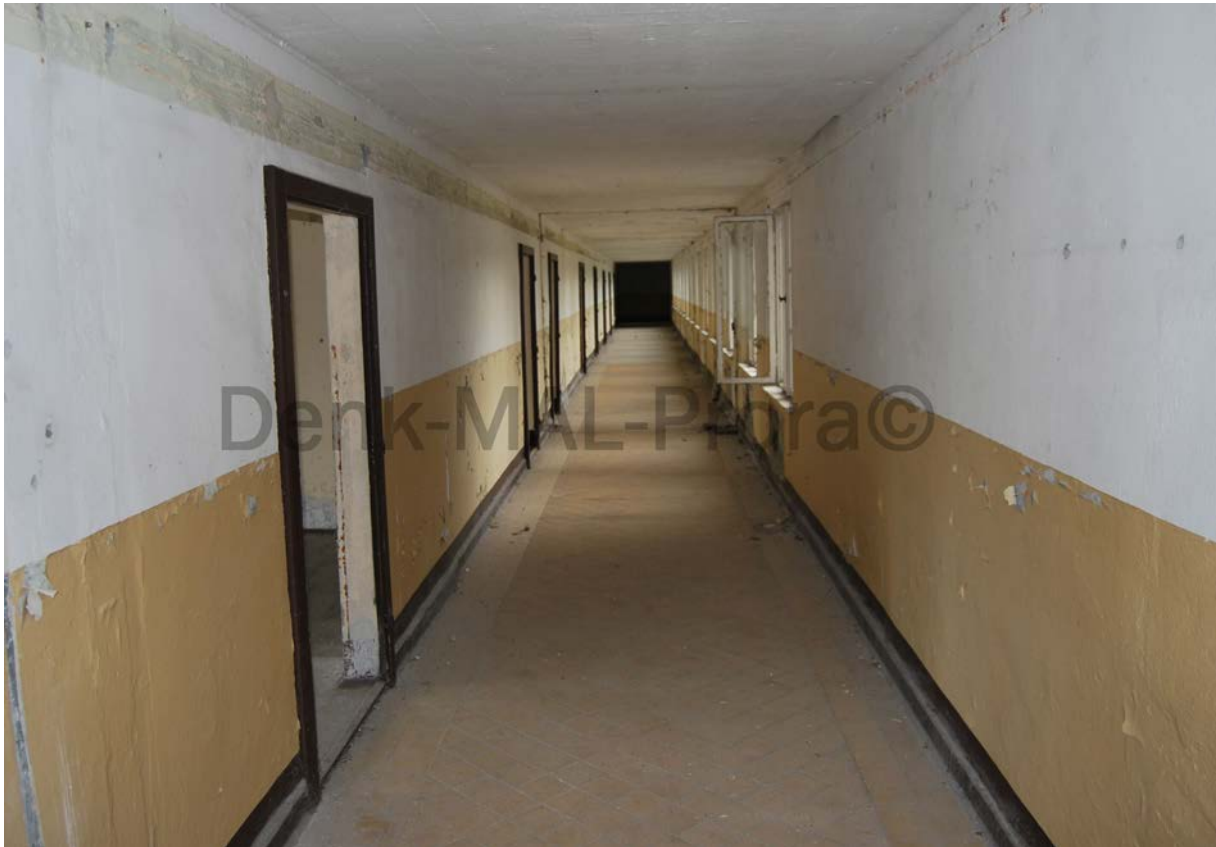
1.OG: Blick in den Kasernenflur nach rechts (Haus Alando)
