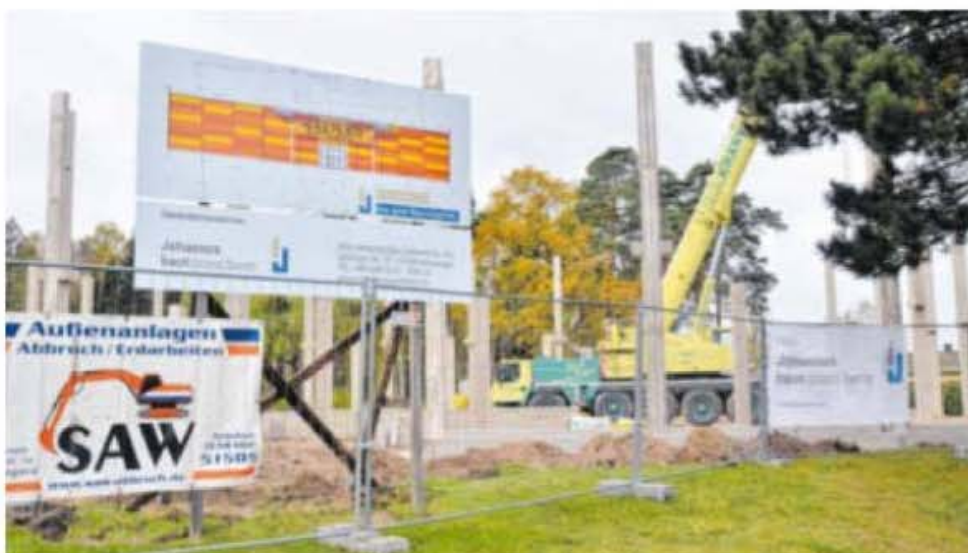
Baustelle an der Einmündung der L 293 in Prora. Hier eröffnet im kommenden Jahr die Galileo Wissenswelt.
