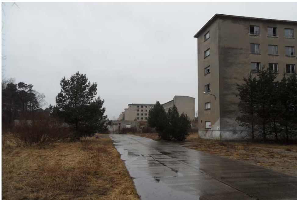
Block IV und der damals unverputzte Block V mit dem seit den 1980er Jahren trennenden Gebäudekomplex dazwischen. Beide Blöcke (südl. Teil Block V) bildeten die Ernst-Moritz-Arndt-Kaserne.
