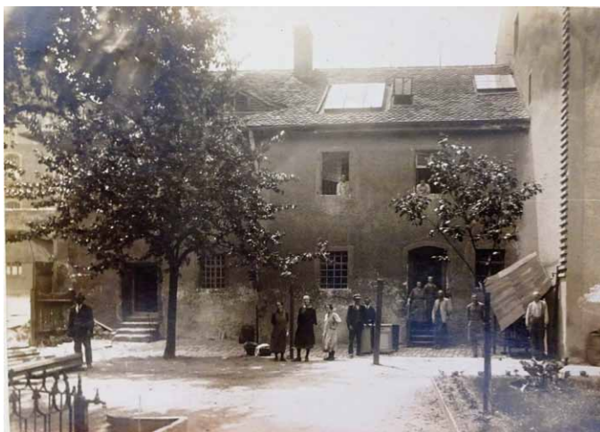
Das Verwalterhäuschen von der Straße und vom Hof aus betrachtet
