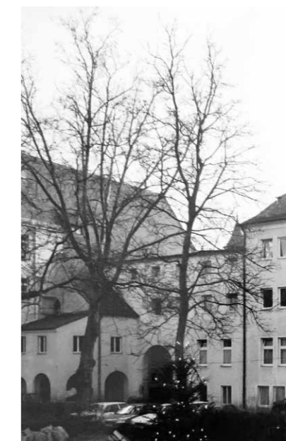
Der Überbau auf dem Torbogen zwischen Krankenhaus und Bruderhauskirche
