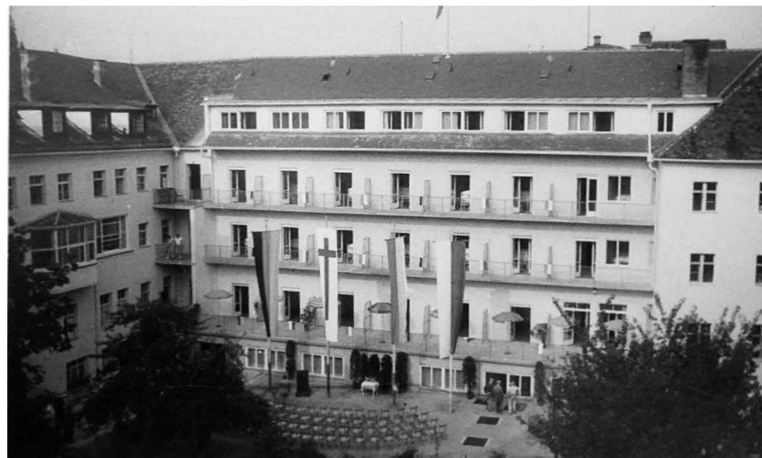
Der sogenannte Balkonbau aus den 1950er Jahren – er wurde um 1990 abermals ersetzt
