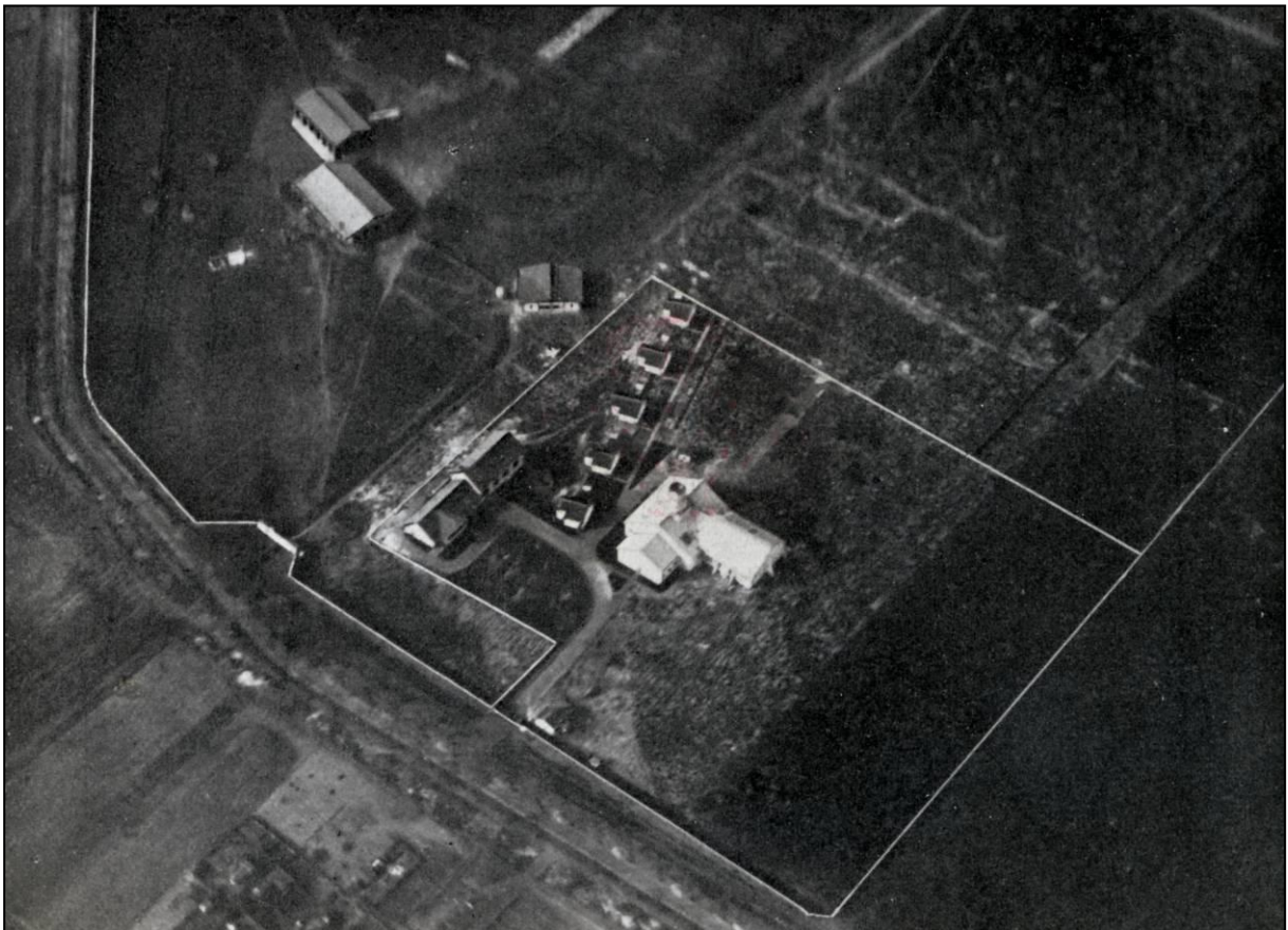
1912 Ansicht aus dem Flugzeug. In der Mitte die Deutsche Versuchsanstalt für Luftfahrt (DVL). Links oben das Fabrikgebäude der Flugmaschine Wright GmbH.
