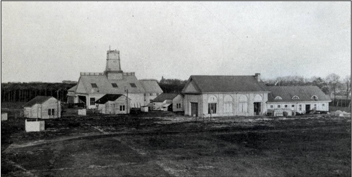
DVL 1912, Ansicht von Südwest.
