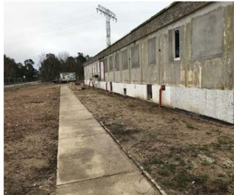
An dieser Stelle in Binz wird gerade das „Deutsches Rügen Museum“ errichtet. FOTO: LARS GROSSMANN
